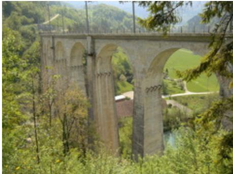
In St-Ursanne befindet sich ein schöner Eisenbahnviadukt. Der Viadukt liegt in einer leichten Kurve und ermöglicht die Eisenbahnquerung eines Seitentales des Flusses Doubs. Gebaut wurde die Brücke 1875 als Fachwerkbrücke mit Spannweiten von 40m. Um 1930 wurde die Brücke umgebaut, und als Viadukt mit Spannweiten um 16m errichtet, in dem neue Pfeiler zwischen die bestehenden gebaut wurden. Für den Ausbau und die Elektrifizierung wurde
